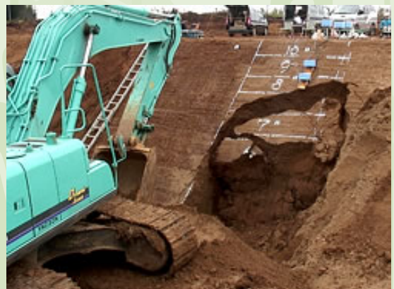
掘削工事における斜面崩壊メカニズム解明のための現場実験
