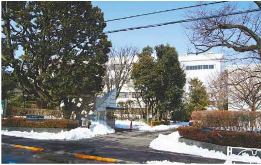
職場における労働者の安全と健康を守る「独立行政法人労働安全衛生総合研究所（清瀬地区）」
