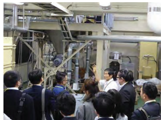
粉体貯蔵槽で発生する静電気放電
