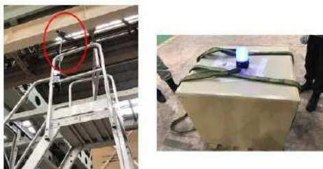
写真 2 カメラと LED の設置状況
