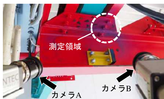
図8 天井クレーンにおける測定領域
