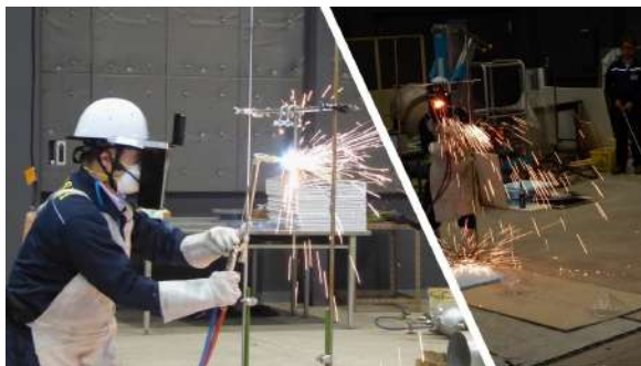
ガス溶断作業における爆発・火災の危険性
