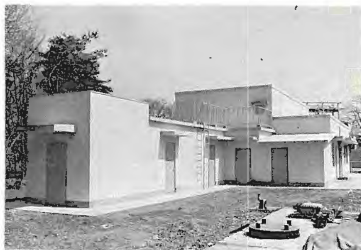
配管など爆発実験施設 (清瀬)
