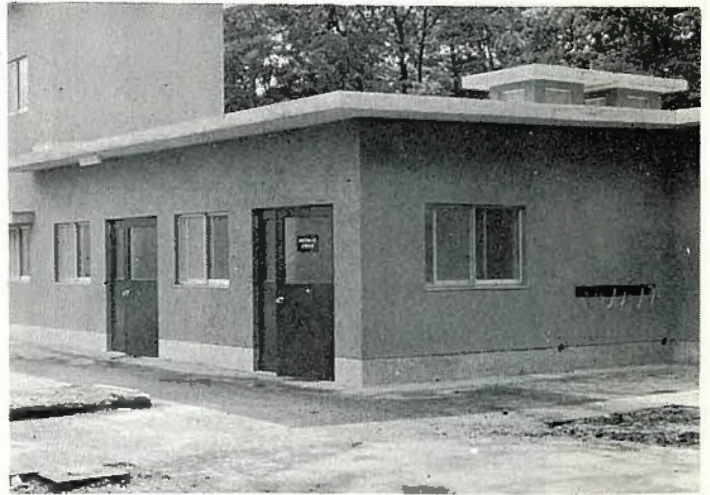
高圧ガス粉じん系爆発実験施設
