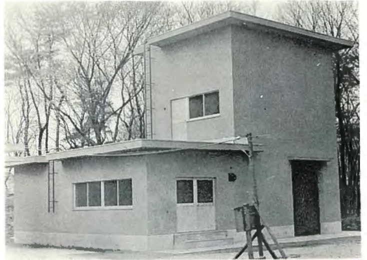
粉じん帯電等実験施設
