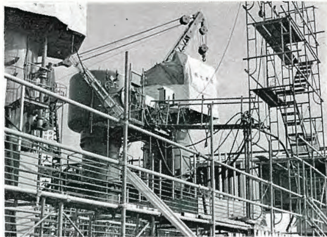
ケーソン工事の実態調査
