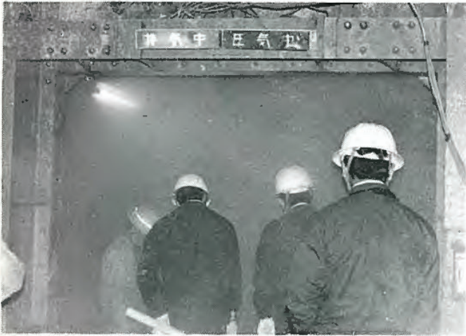
作業室内の実態調査
