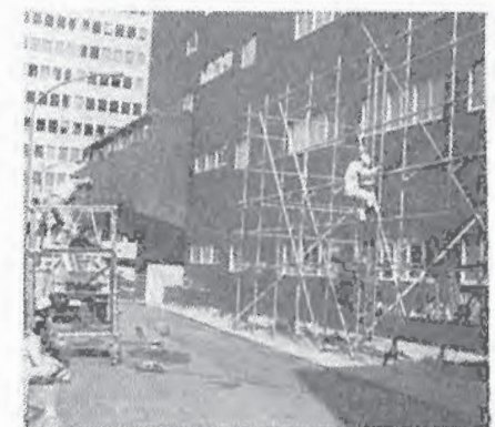
写真 4 足場実験Ⅰの様子
