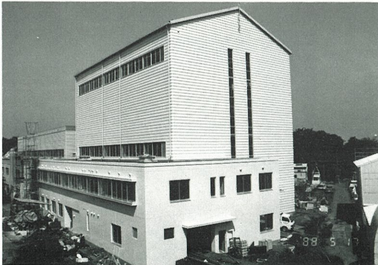
竣工間近い建設安全実験棟
