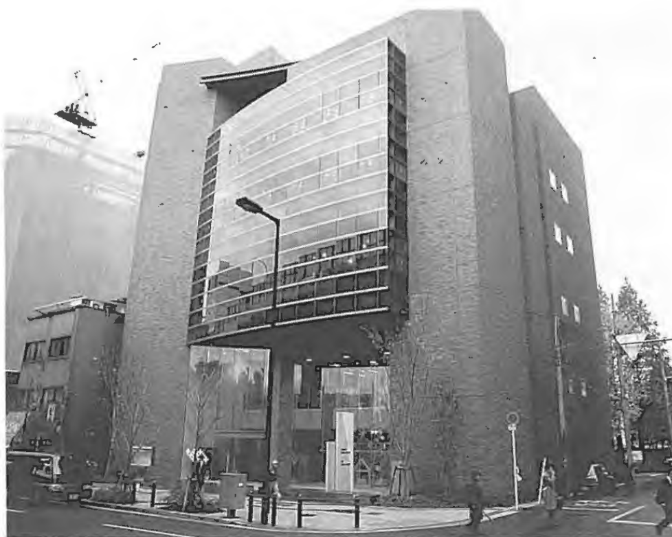
大阪産業安全技術館新庁舎
