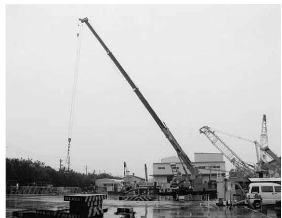
図3 ボックスジブクレーン測定の様子
