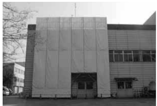
写真1 7層6スパンの実測用わく組足場
