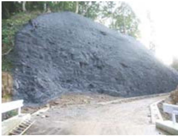
図 3.9 吹付けコンクリート工
