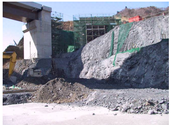
図 3.13 切りなおし、鉄筋挿入工+頭部連結
