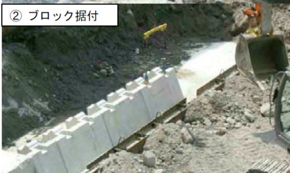
図 2.30 無人化施工対応自立式型枠ブロック施工例
