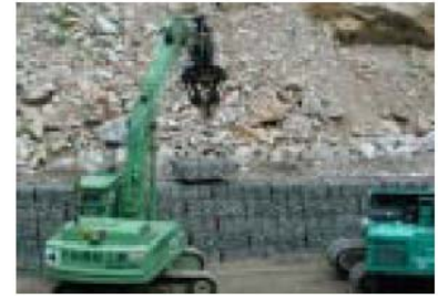
図 2.27 カゴ杵設置状況
