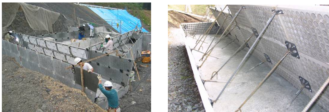
図 2.11 施工例（半径 10m 以下の曲率には適用不可）
