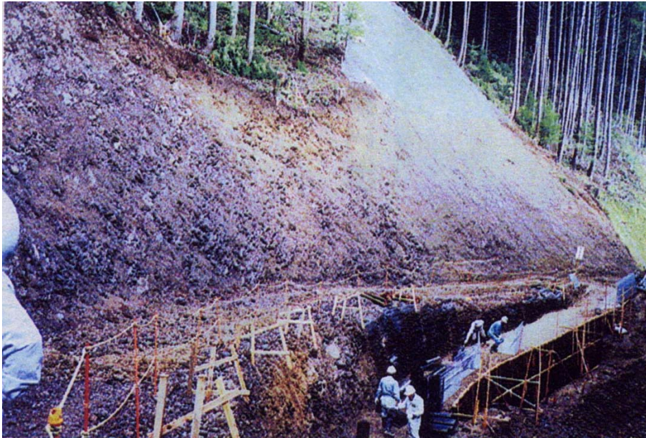
図-2.7 切土斜面直下における擁壁工の施工状況の一例
