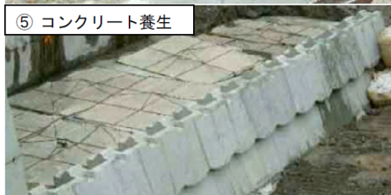
図 2.30 無人化施工対応自立式型枠ブロック施工例
