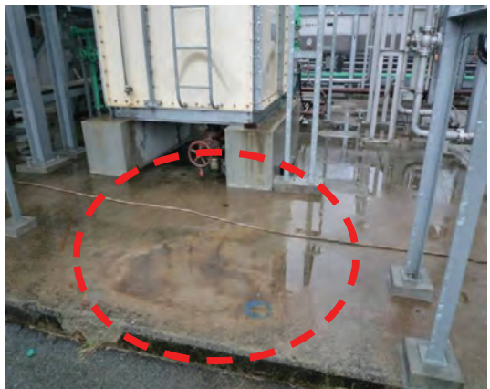
●該当箇所の花壇を撤去した。
