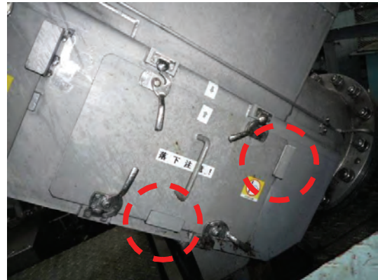
●落下防止の金具を設置した。
