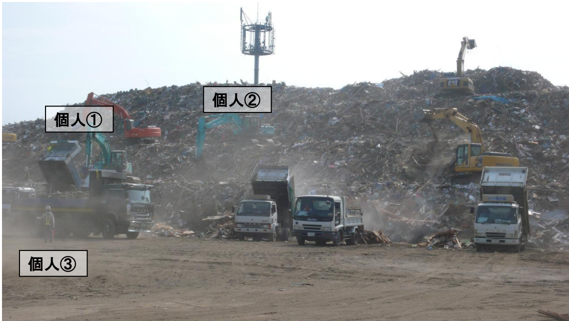
図 4 重機による作業の様子(がれき集積場 A・東側から)
