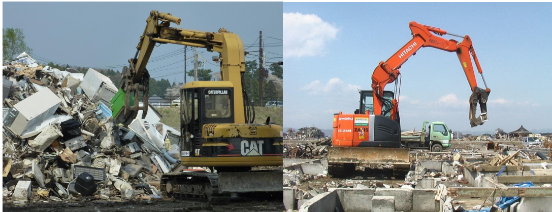
がれき除去作業中のグラップル
