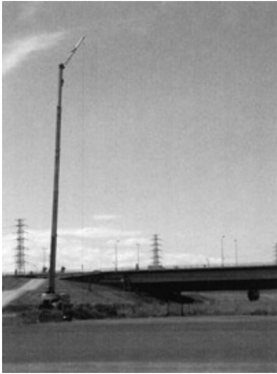
Fig. 7 Setting of a rough-terrain crane. ラフテレーンクレーンの設置状況
