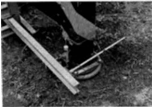
Photo. 2 State of outrigger sinking experiment アウトリガの沈下実験の状況
