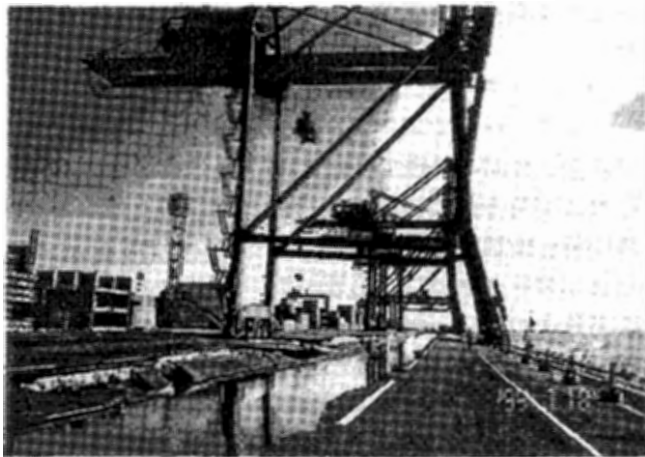
Photo 9 Derailed from rail and buckling of leg of container crane. 脱輪および脚部が変形したコンテナクレーン
