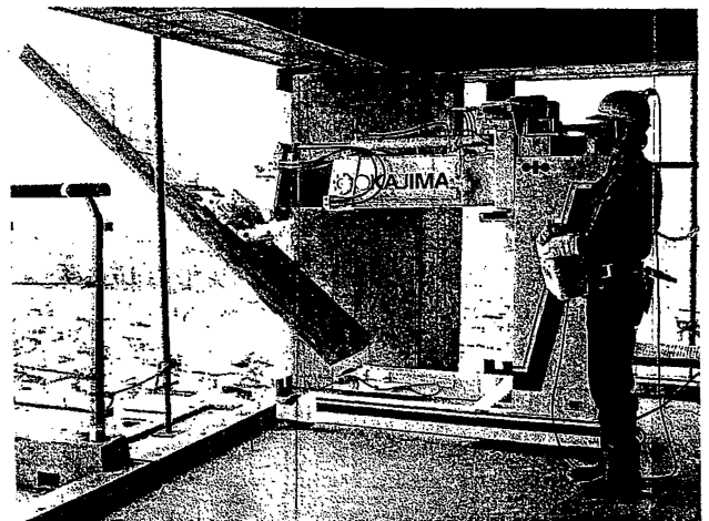
Fig. 4 Panel installation using versatile handling robot. 多目的建設ハンドによる外壁取付作業
