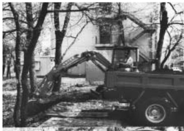
Photo.3 Work situation(beginning) 作業状況(掘削開始時)
