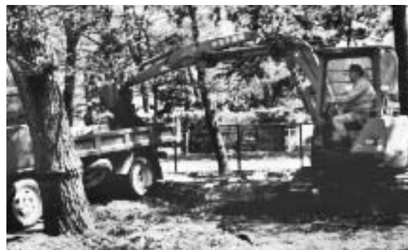
Photo.6 Work situation(loading) 作業状況(積み込み)
