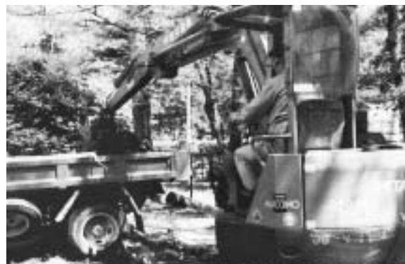
Photo.5 Work situation(left turning) 作業状況(左旋回)
