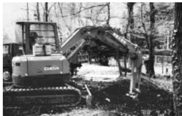
Photo.4 Work situation(excavating) 作業状況(掘削中)
