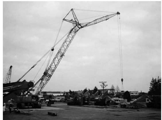
Fig. 2 Photo of measured crane ヤード内測定の様子
