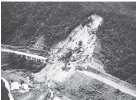
Photo 1 Failure in cut slope. 高速道路の切土斜面の崩壊事例
