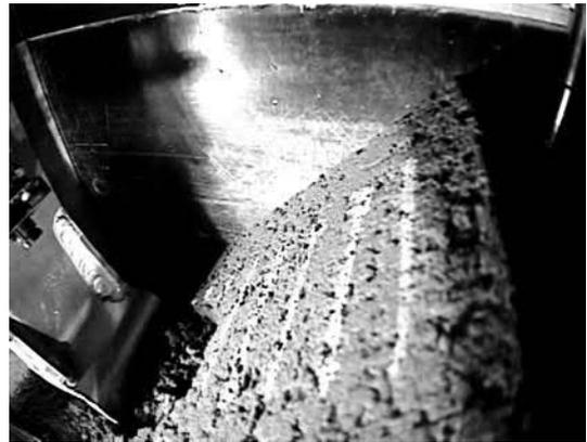
(b) 1.5m 掘削時の部分崩壊
