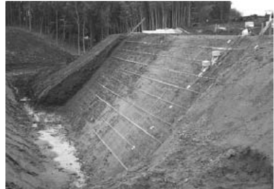
図1 実物大規模実験に使用した試験盛土
