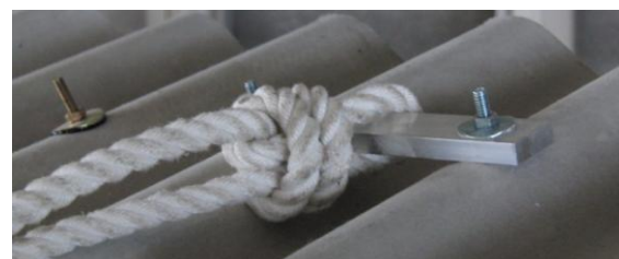
写真2 親綱取付金具に親綱を取り付けた例
