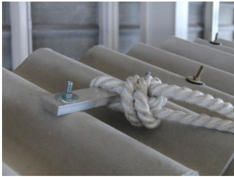
図4 組立手順② (親綱または緊張器付き子綱の接合)
