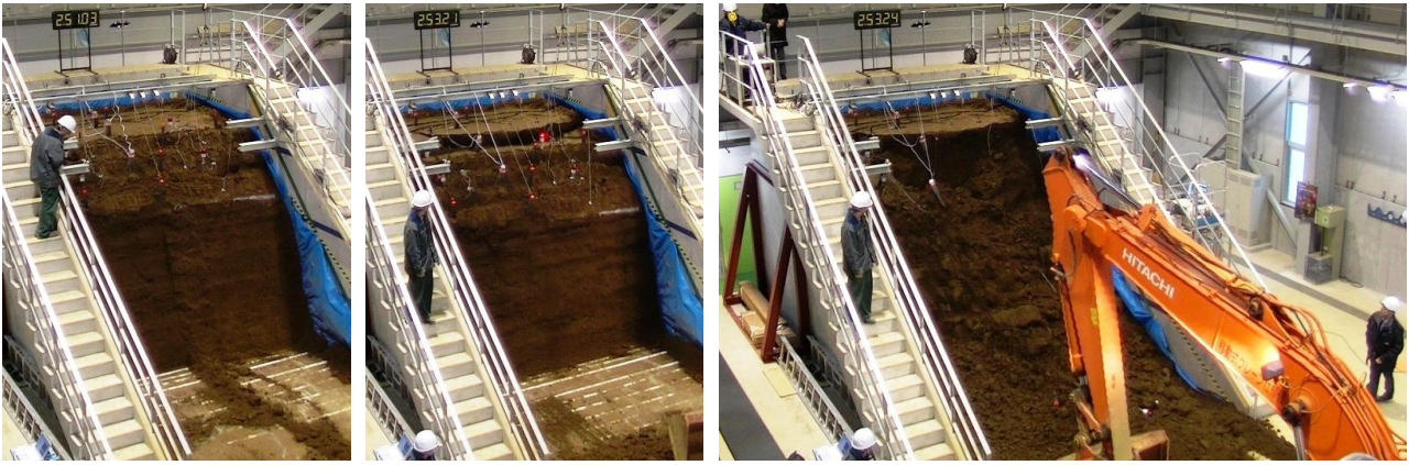
(a)崩壊 3 分前 (b)崩壊直前 (c)崩壊直後
