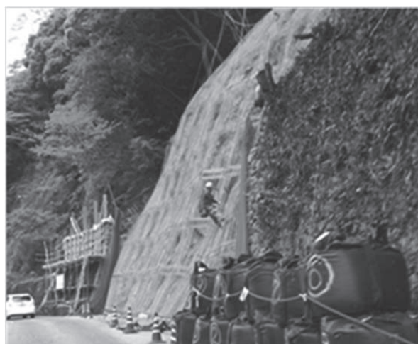
図2 法面工事による作業の一例
