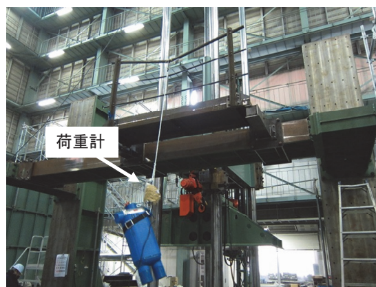
図5 落下実験後の状況(上段手すりに安全带を掛けた場合)
