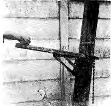
図 1 作業用仮足場
