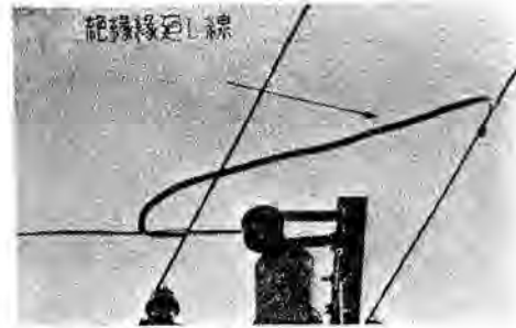
図2 高圧線廻し線
