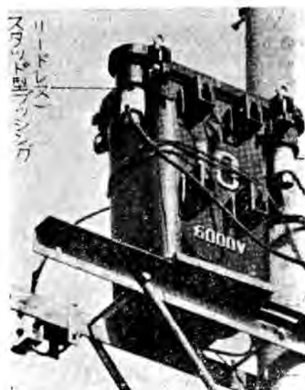
図4 変圧器スタッド型ブッシング
