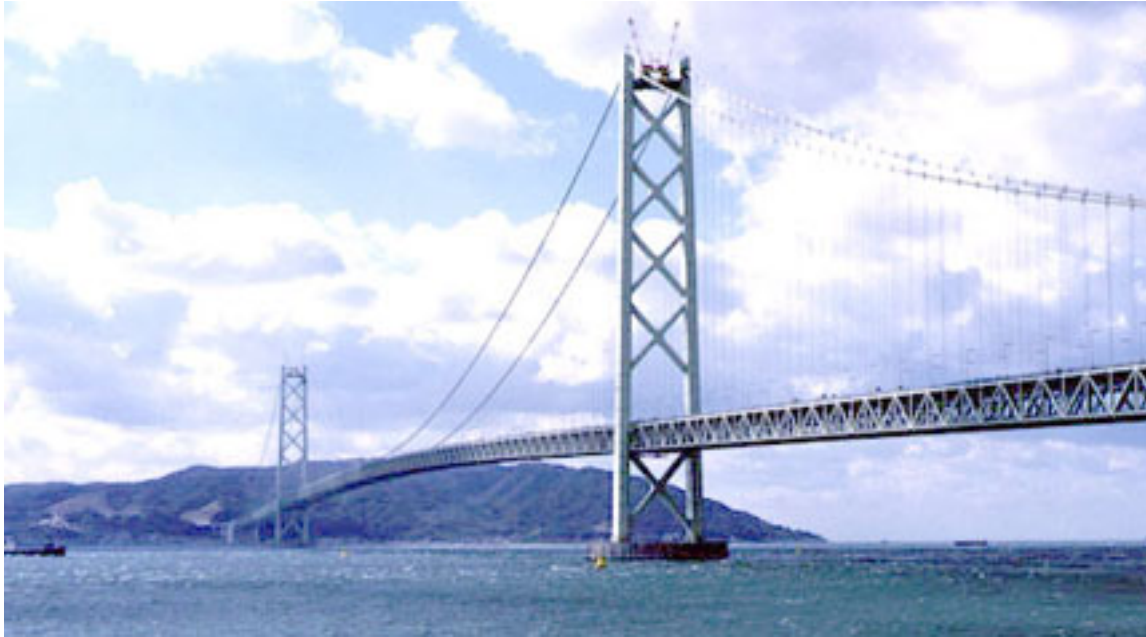
明石海峡大橋
