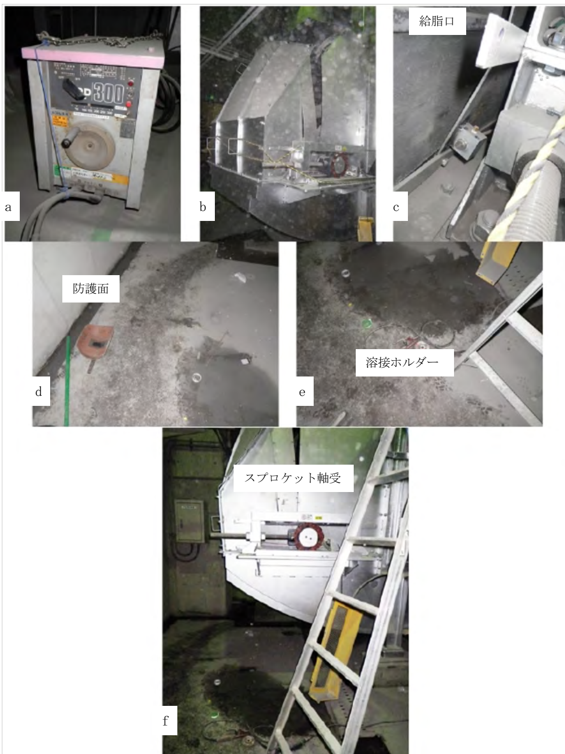
図 7: 溶接作業 ; a: 溶接機, b: スプロケット軸受部ユニット, c: 溶接部の給脂口, d, e: 溶接用道具, f: アースクランプとそのケーブルが見当たらない
