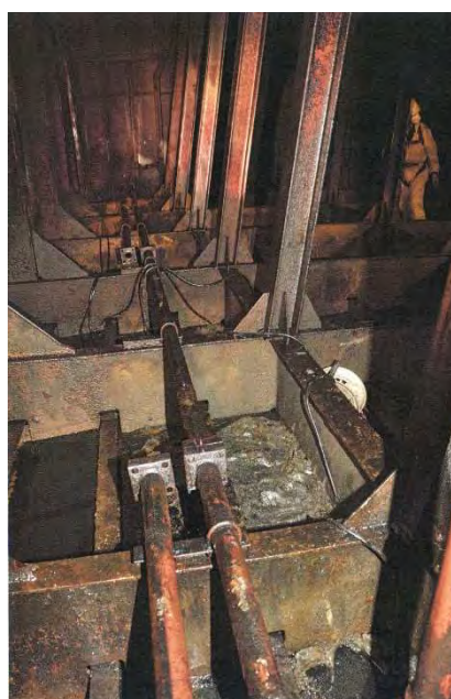
写真 3 油圧配管を船尾方向に見たところ
