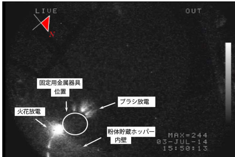
写真2 固定用金属器具とホッパー内壁との間で発生した静電気放電
